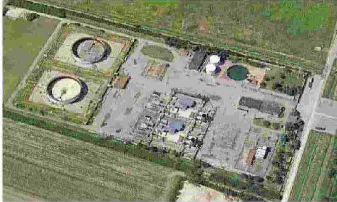
La centrale Enel Turbogas di Fossoli la cui area è stata dismessa
