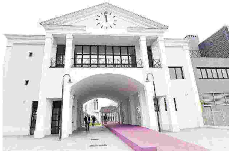
VIA DEL FONDITORE La sede storica, completamente rinnovata
