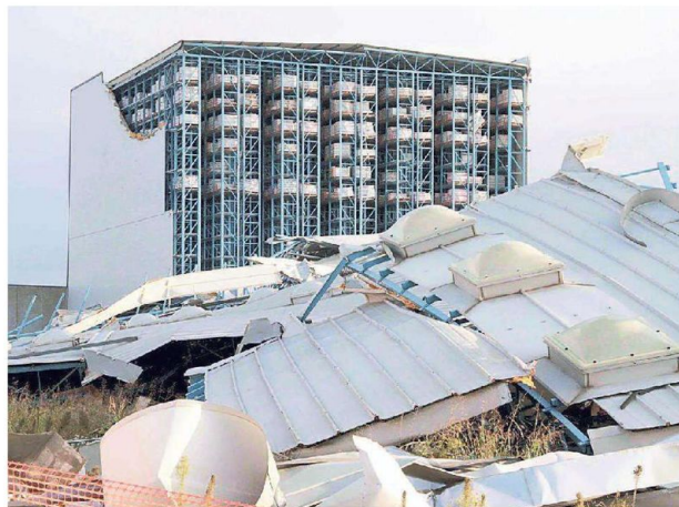
Il capannone crollato alla Ceramica Sant'Agostino
