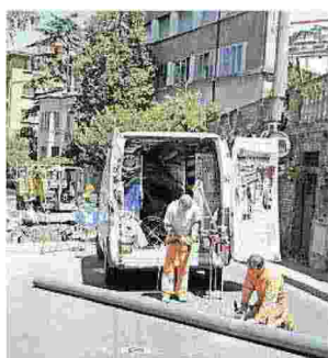
Operai di Hera su un cantiere
